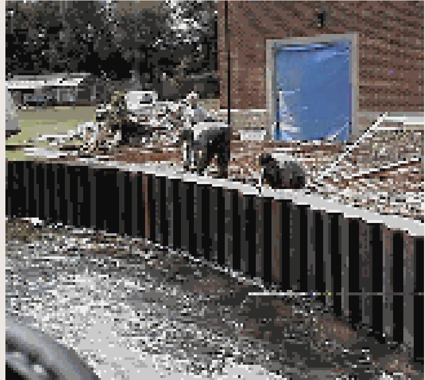
Πασσαλότοιχος από Πασσαλοσανίδες
