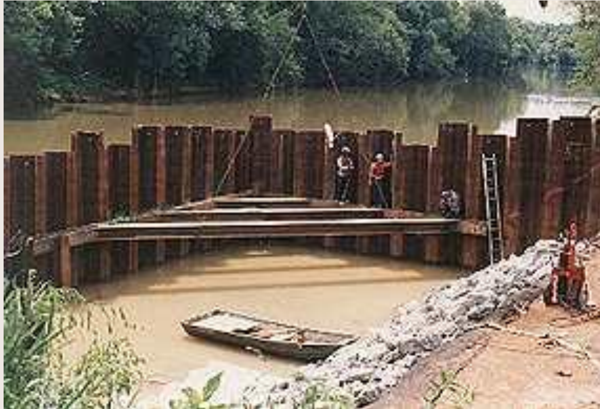
Πασσαλότοιχος από Πασσαλοσανίδες
