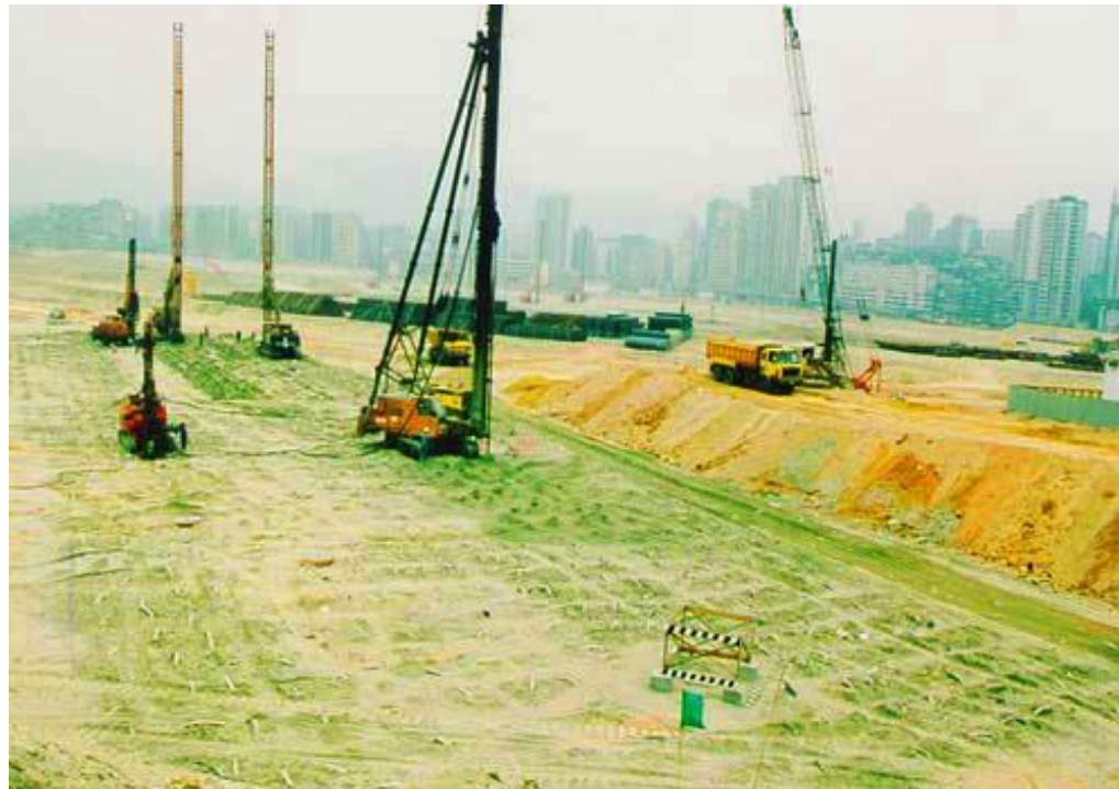
Εγκατάσταση των PVD
